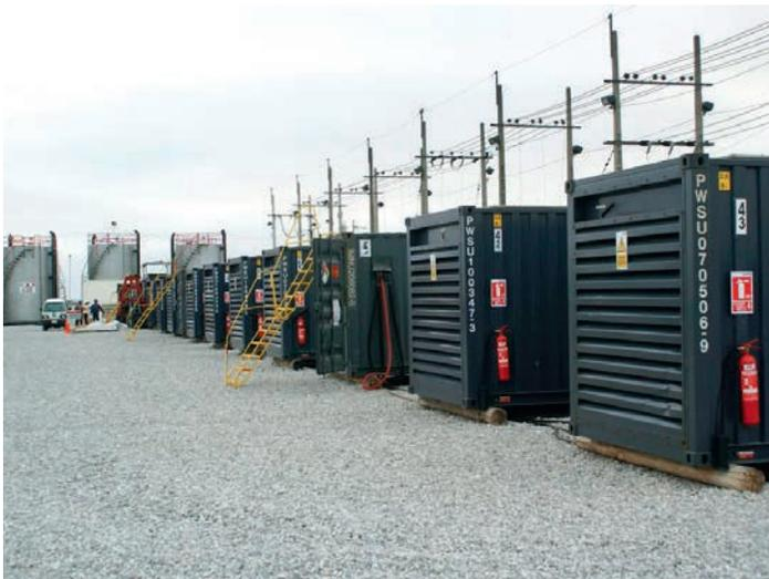
Estas plantas de generación, de origen europeo, están diseñadas para generar, en baja y media tensión, desde los 400V a los 30 KV, adecuados para todo tipo de conexiones y aplicaciones en operación continua o emergencia. Estas unidades modulares, compuestas por grupos electrógenos Cummins integrados en contenedores insonorizados de 20", permiten implementar soluciones rápidas y eficientes, desde los 2 a 50 MW, pudiendo operar en todo tipo de condiciones climáticas o altura geográfica.
