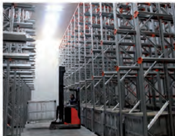
Drive In - Cámara de Frío
