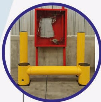
Cliete: Soprole S.A. Productos: Bollard - TB400
