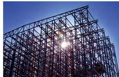
En los almacenes autoportantes la estantería forma parte de la propia estructura del edificio, por lo que soporta una carga muy superior a la del almacén convencional, sumando la carga de la mercancía almacenada, la carga de los cerramientos exteriores y la de las fuerzas externas como el viento y nieve. Son almacenes que en su mayoría cuentan con sistemas automáticos y equipos robotizados para la manipulación de la mercancía.
